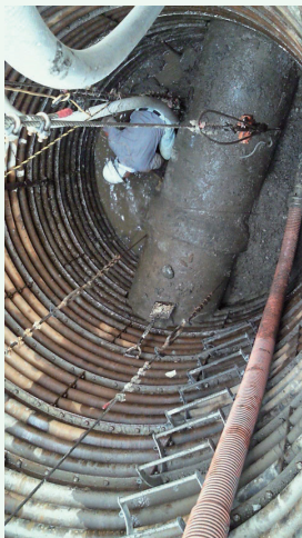
■ WRJ 取付前の立坑内
