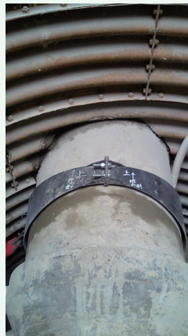
■ WRJ 取付後の状況
